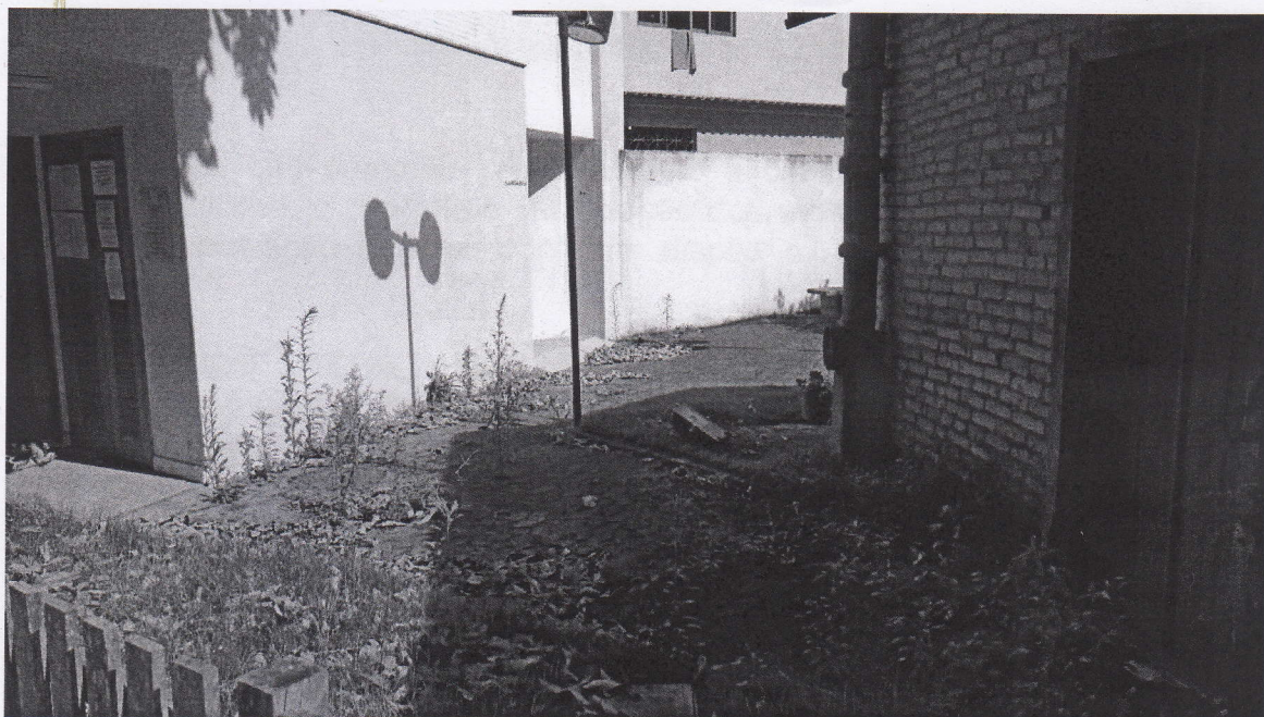
Foto 1: entorno do imóvel sem manutenção.
