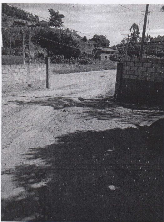
Foto 02 – acesso à EMEIEF Vale de Tabocas sem portão (proximidade da rodovia)
