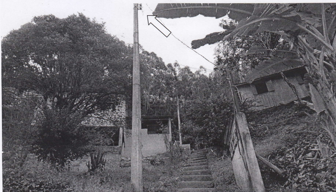
Foto 02 – Poste sem iluminação pública
