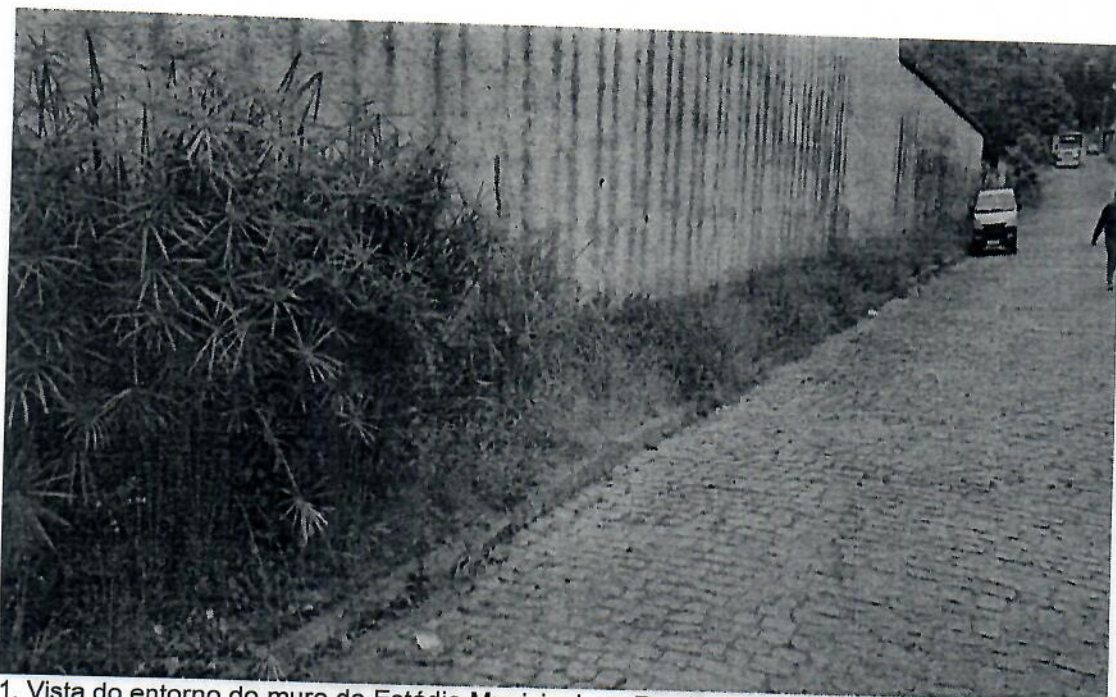
1. Vista do entorno do muro do Estádio Municipal, na Rua Vicente da Costa Oliveira
