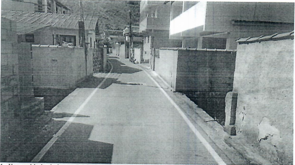
1 - Necessidade de inserção de guarda-corpo nas laterais da ponte - Rua Victório José Pozzatti.
