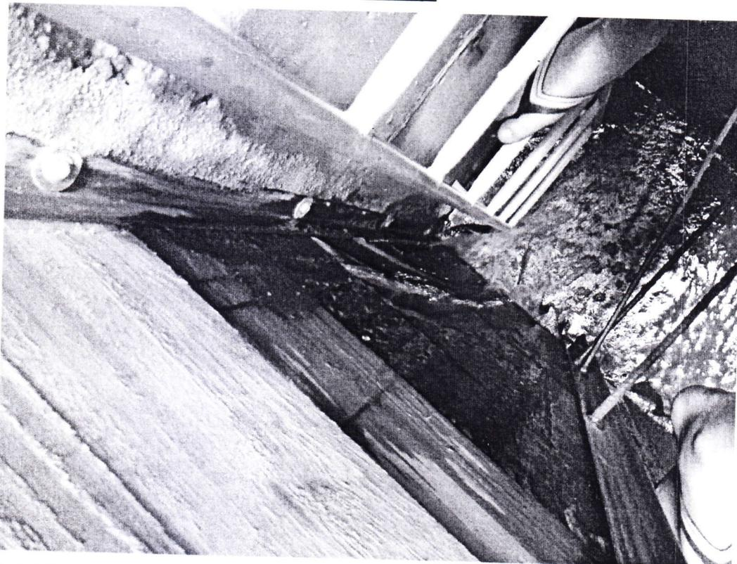
Foto 02 – vazamento de água nas laterais do monge
