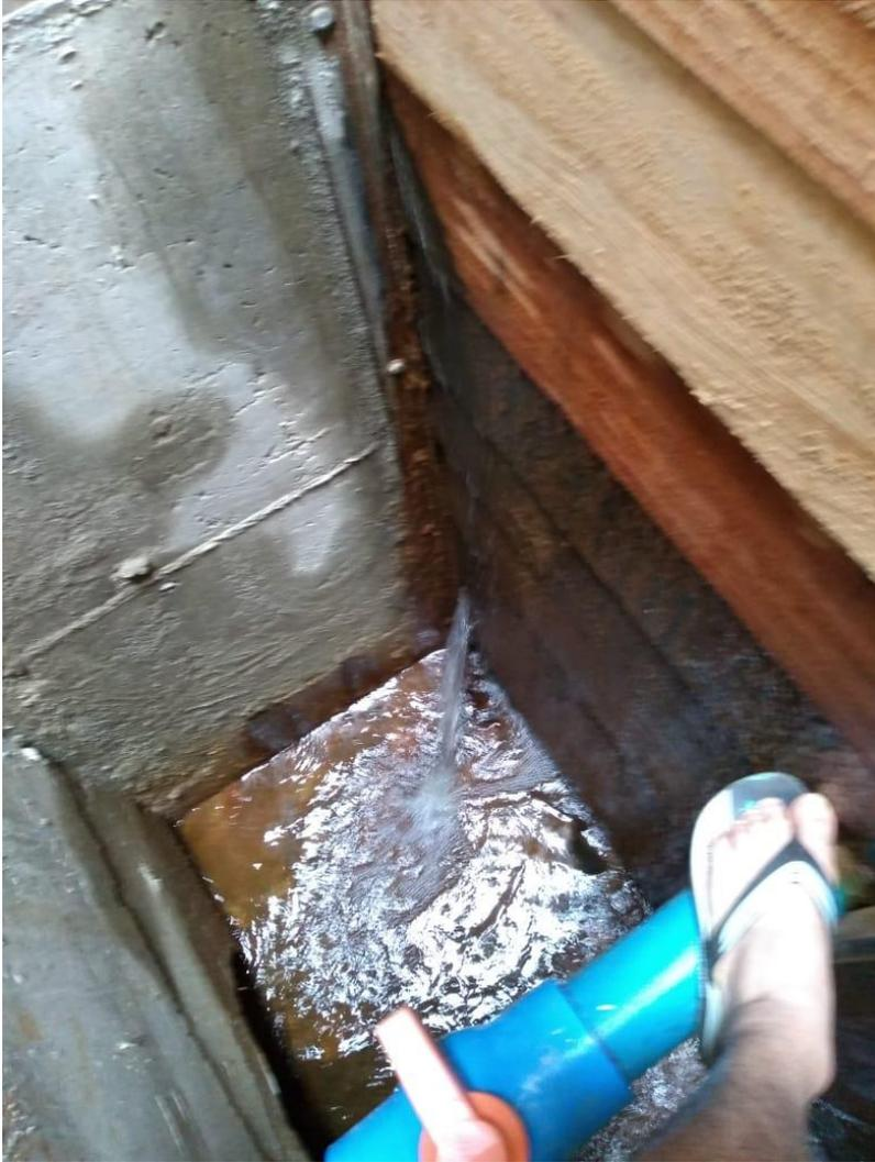
**Foto 03 – vazamento de água nas laterais do monge**
