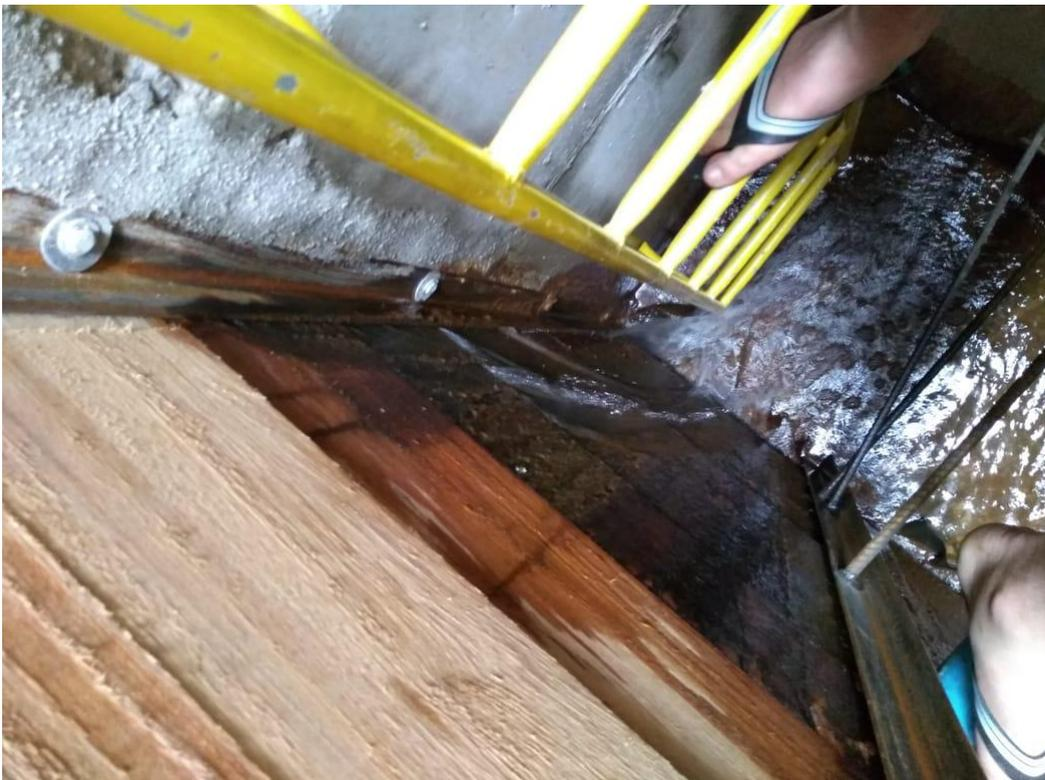
**Foto 02 – vazamento de água nas laterais do monge**
