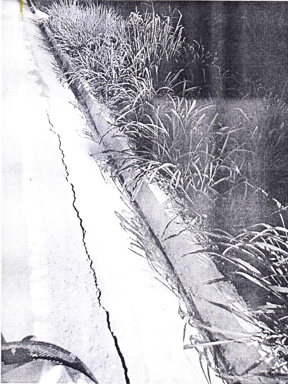
Foto 01 – imagem da fissura que se abriu na canaleta
