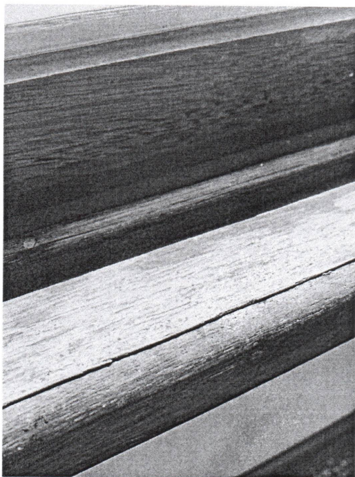
Foto 02 – Vista de janela sem pintura (que estava prevista no projeto)
