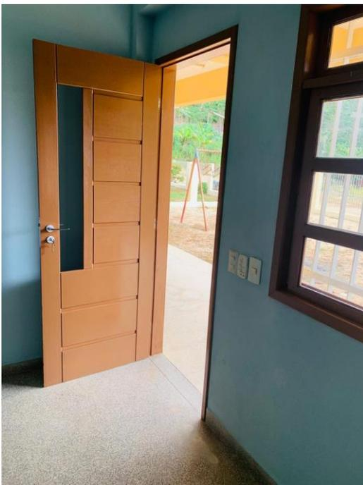
**Foto 04 – sala dos professores a janela possui grade, mas a porta não e isso trem facilitado arrombamentos**
