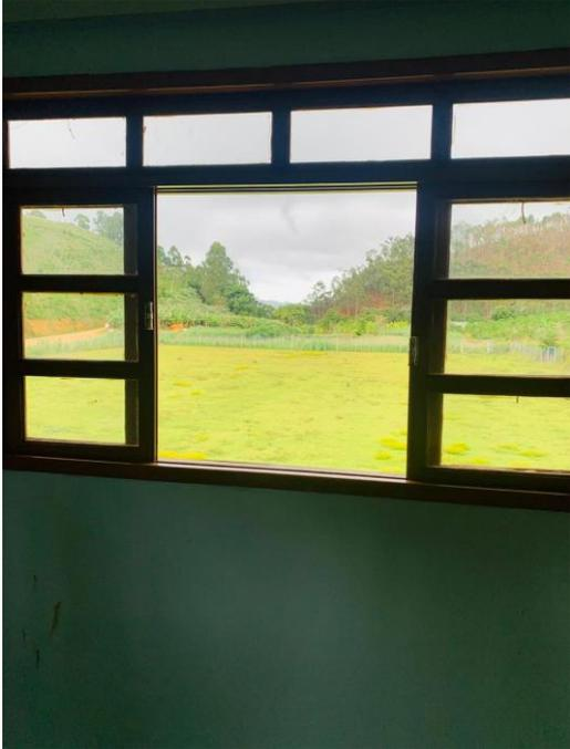
**Foto 03 – falta de grades nas janelas do lado do campo (bolas atingem as janelas e quebram a estrutura)**
