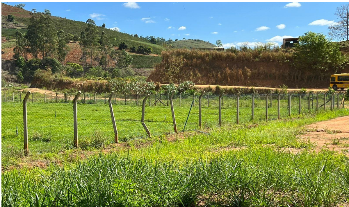
1. vista do campo de 25 de Julho, com estacas de sustentação do alambrado danificadas
