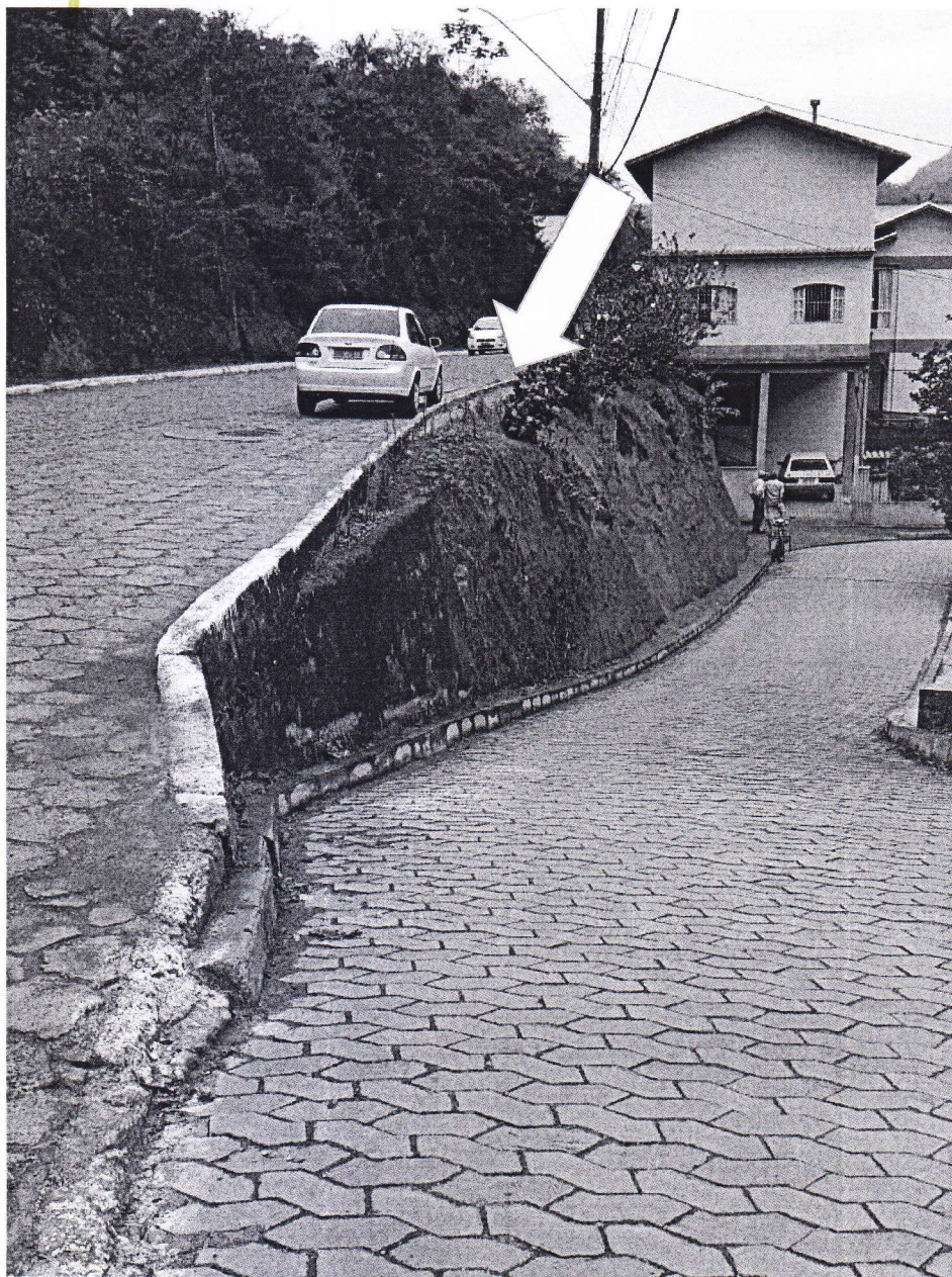
2. trecho da rua São Lourenço onde há necessidade de complementação do passeio de pedestres
