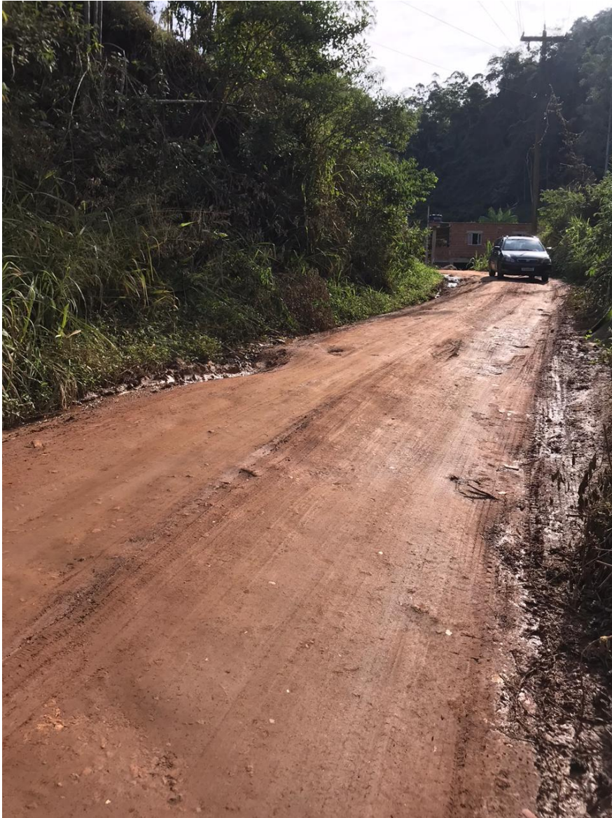
Foto 2 - outra imagem da estrada vicinal onde precisa ser instalada a “boca de lobo”
