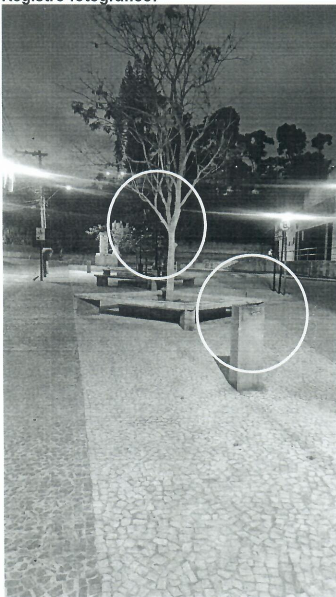
1 - Iluminação interna da Praça José de Anchieta Fontana, danificada.
