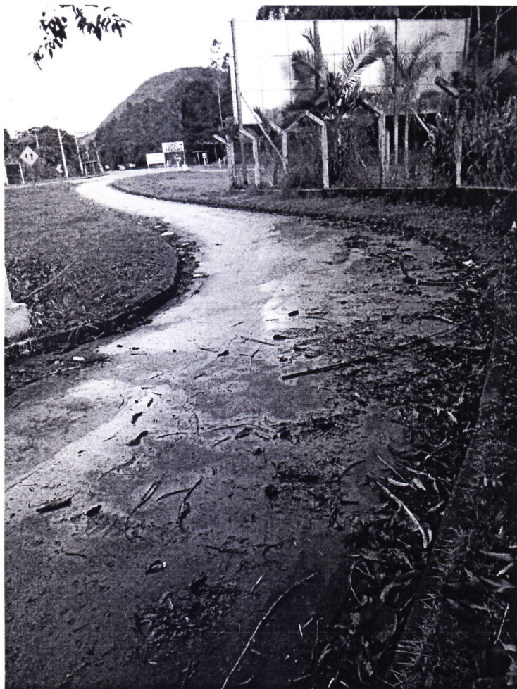
1. vista de trecho escorregadio da faixa multiuso
