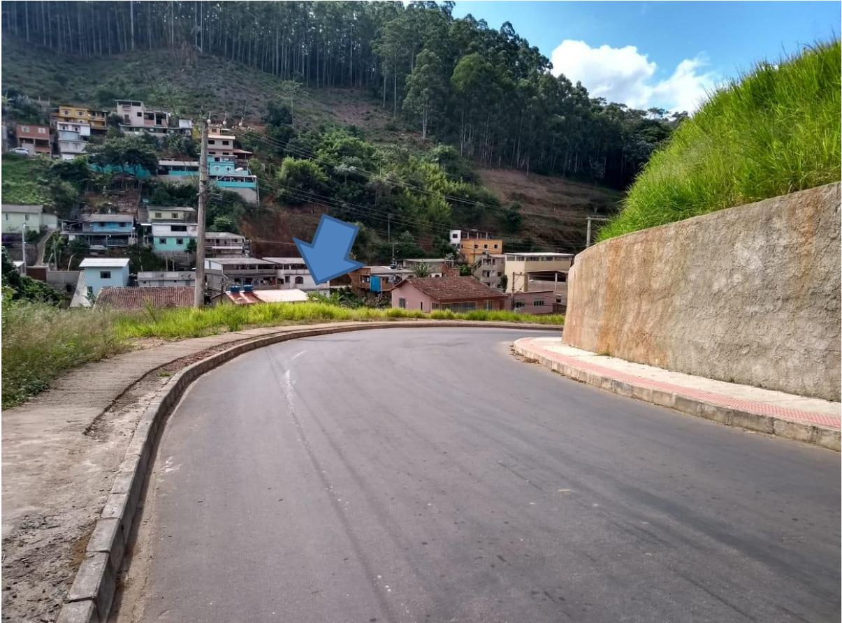
**Foto 1 - curva acentuada situada na Ladeira Fortunato Carlos Bonino, após longo trecho em declive (onde um veículo, com falha nos freios, pode precipitar-se sobre a calçada da Av. Barão Orlando Bonfim, situada no nível abaixo do talude)**
