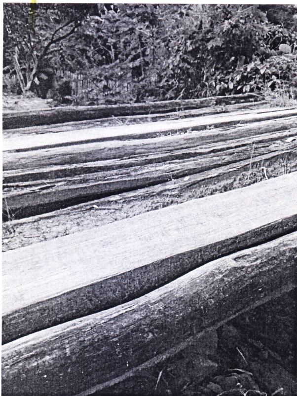
Foto 1 – vista da estrutura da ponte em madeira
