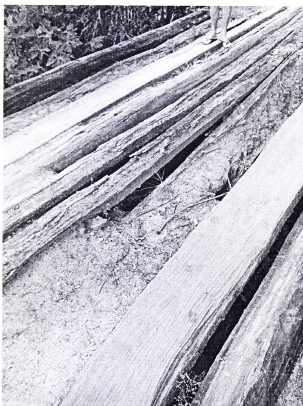
Foto 2 – vista da estrutura da ponte com frestas entre as vigas
