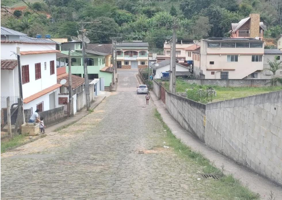
**1 - buracos com necessidade de reassentamento dos paralelepípedos, via precisando de capina**
