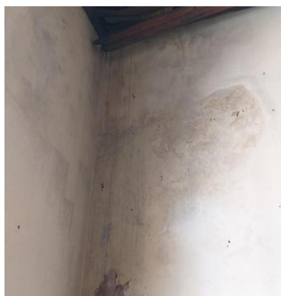
**1 - situação das paredes, com diversos pontos de infiltração, mofo, degradação da pintura, situação que pode comprometer o acervo**
