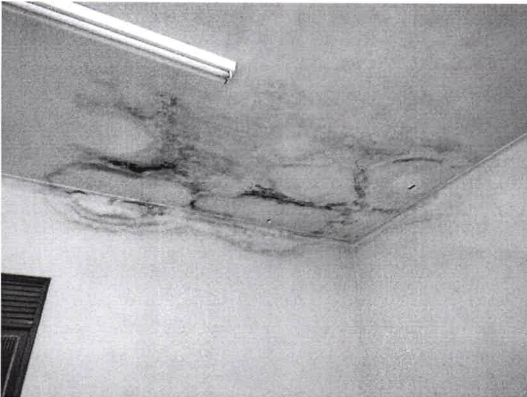
2 - situação do teto, devido a infiltrações
