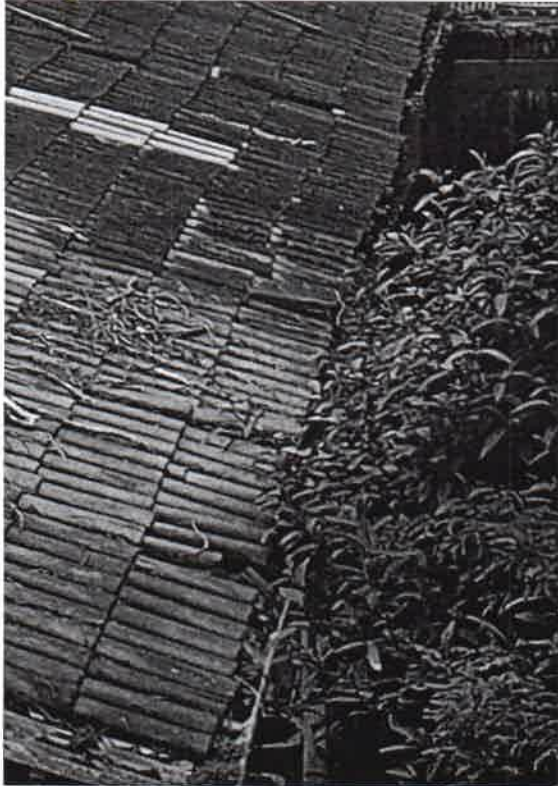
1 - vista do telhado do prédio do Polo UAB - Santa Teresa
