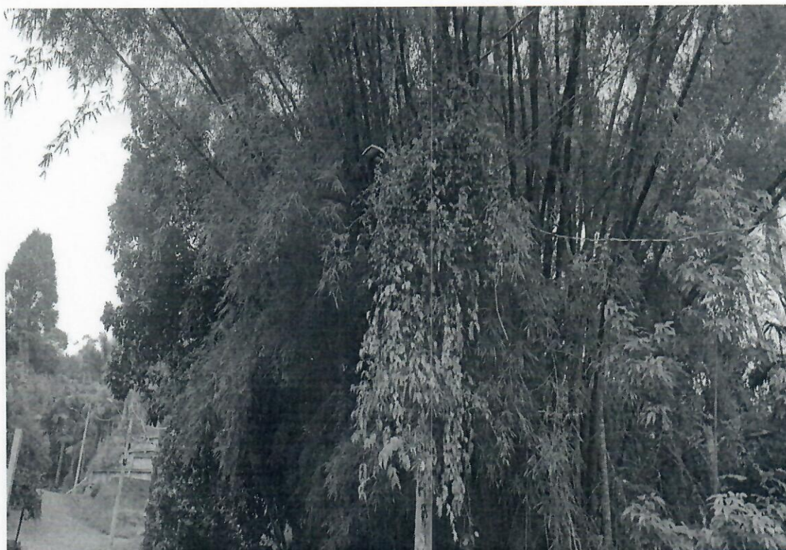
4. Bambuzal sobre a linha de transmissão de energia elétrica
