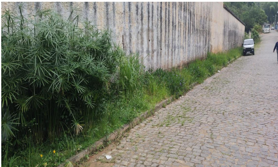
1. Vista do entorno do muro do Estádio Municipal, na Rua Vicente da Costa Oliveira
