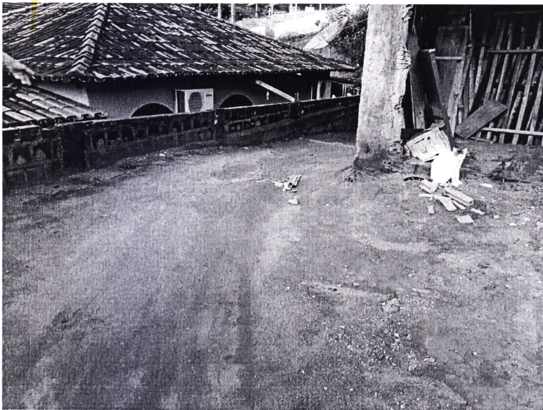
Foto 3 - vista de outro ponto da rua Olívio Cozzer (pavimentação)
