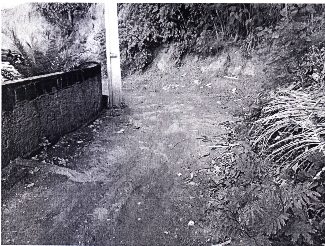
Foto 2 - vista de outro ponto da rua Olívio Cozzer (pavimentação)
