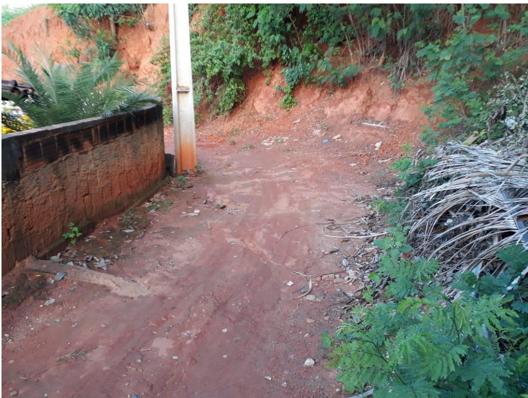
Foto 2 - vista de outro ponto da rua Olívio Cozzer (pavimentação)
