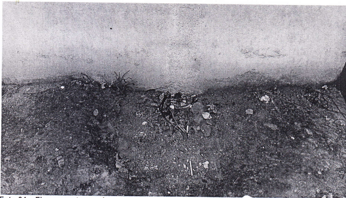
Foto 04 – Fios expostos na área externa
