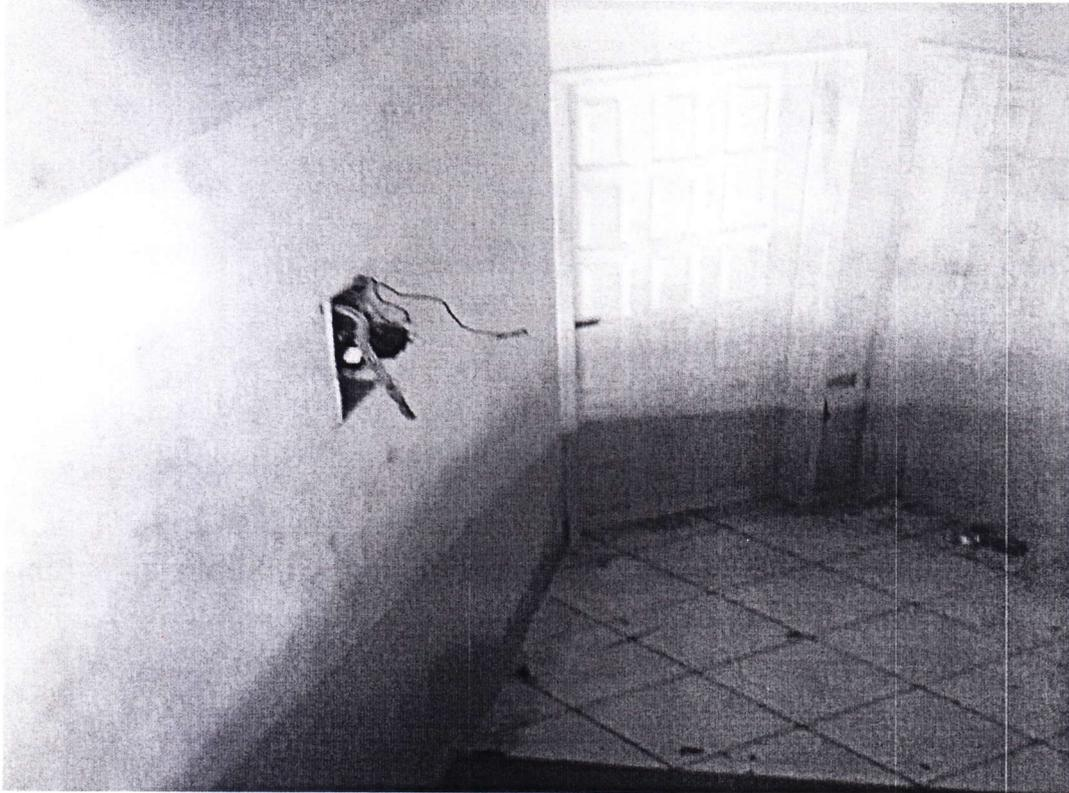
Foto 07 – Parte elétrica expostas provocando riscos iminentes
