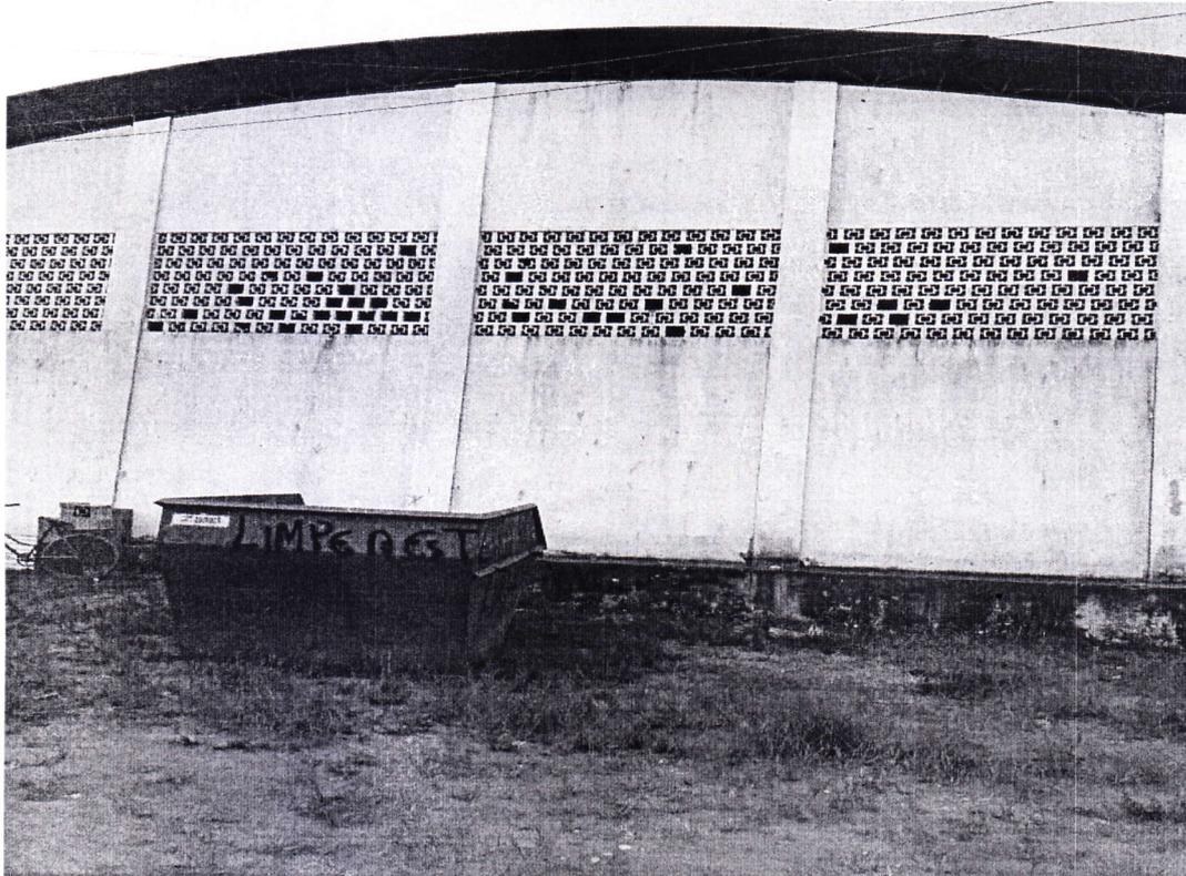
Foto 04 – Janelas com vários elementos vazados de concreto (comungol) quebrados
