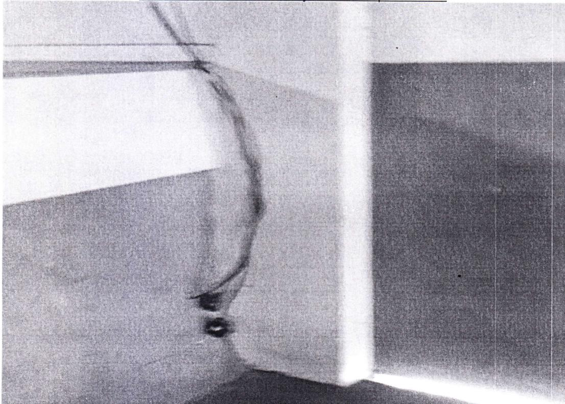
Foto 06 - Parte elétrica expostas provocando riscos iminentes
