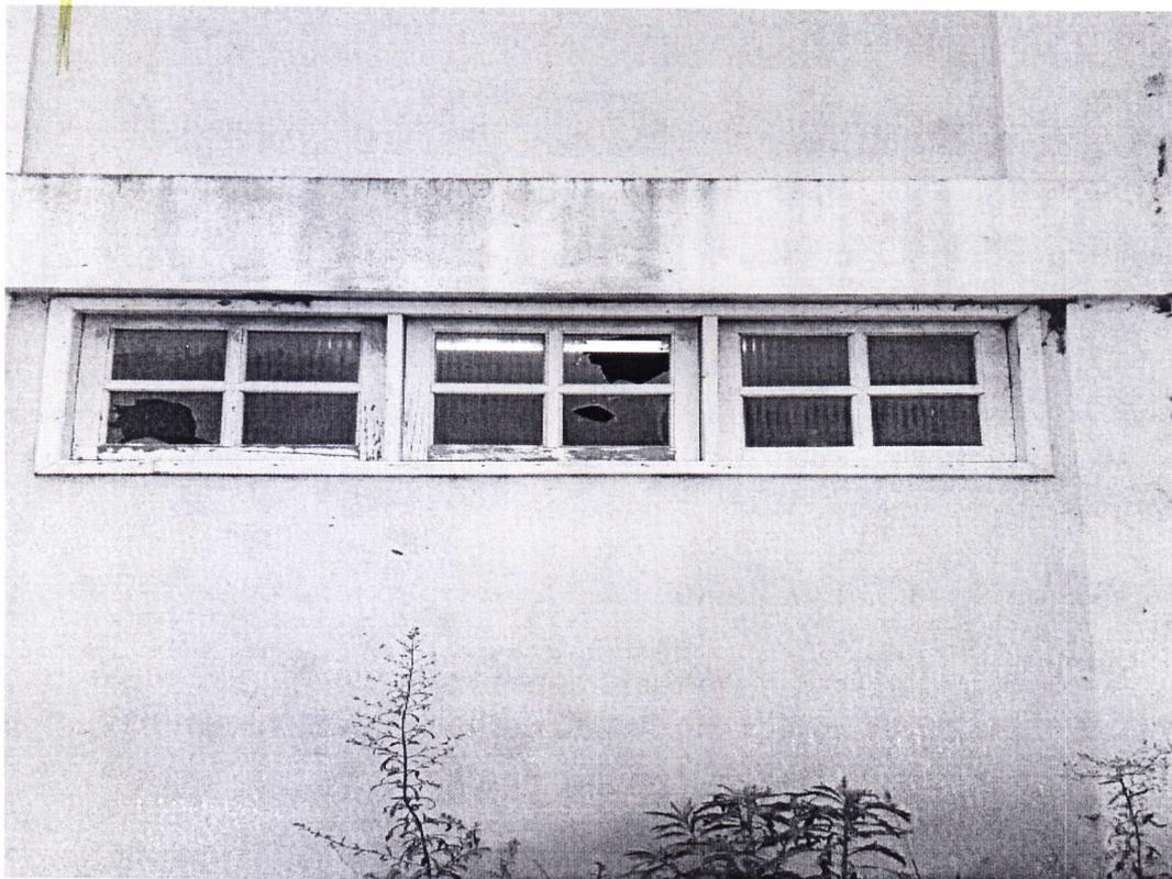
Foto 01 – Janelas com vidros quebrados
