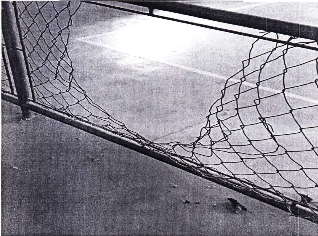
Foto 08 - Alamedado com nível avançado de deterioração
