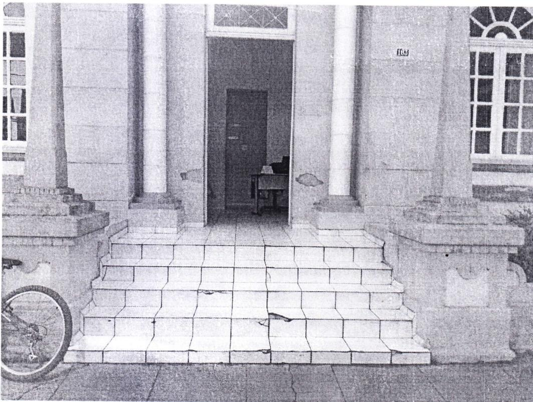
Foto 2 - Foto aproximada destacando as imperfeições do imóvel (piso, parede quebrados, sujeira.)
