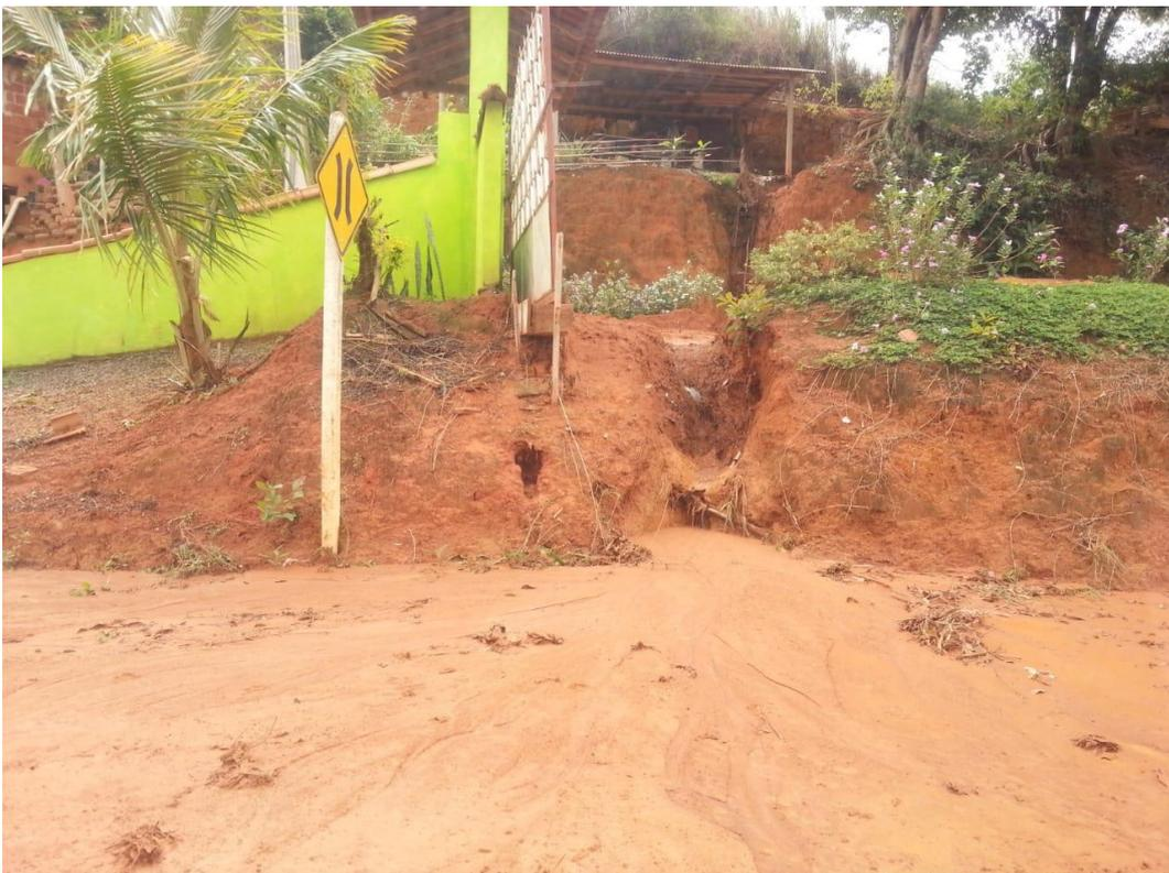
Foto 2 - A lama se origina de processo erosivo à margem da rodovia
