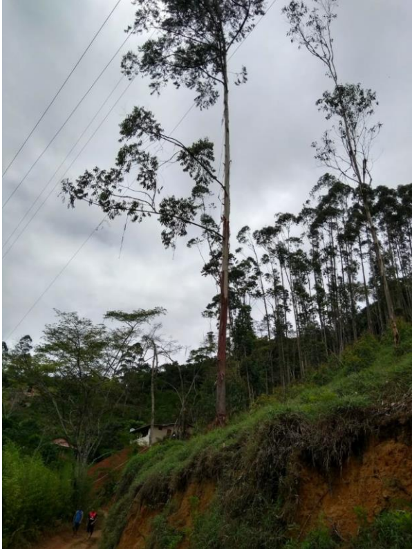
Foto 5 - Presença de árvore exótica em risco de queda sobre a rede elétrica e residências
