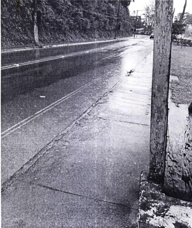
Foto 1 - Situação de alagamento no ponto de ônibus após o INSS (bueiro obstruído)
