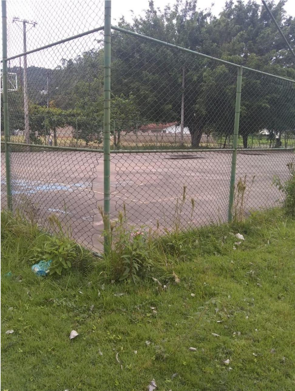
Foto 2 - vista do alambrado danificado, precisando de substituição
