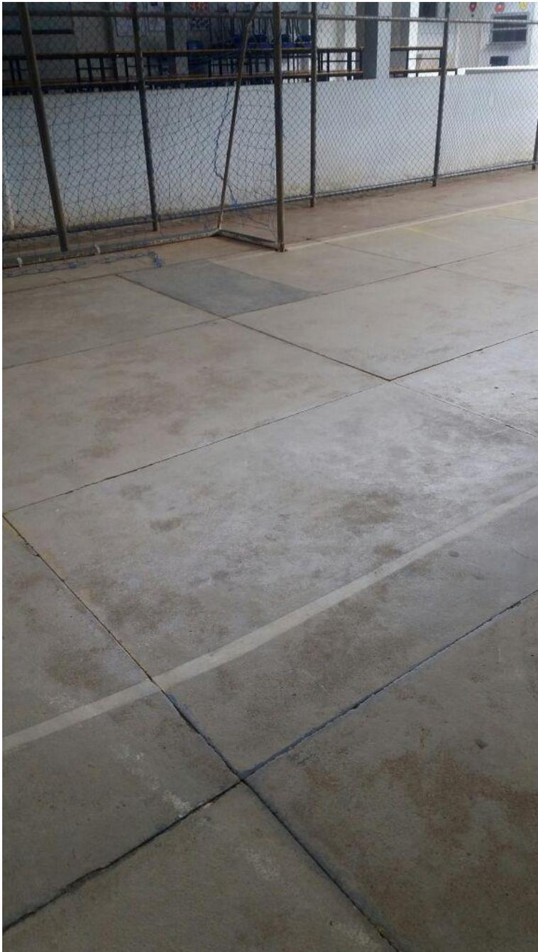
**Foto 02 – Piso com ressaltos e alambrado danificado**
