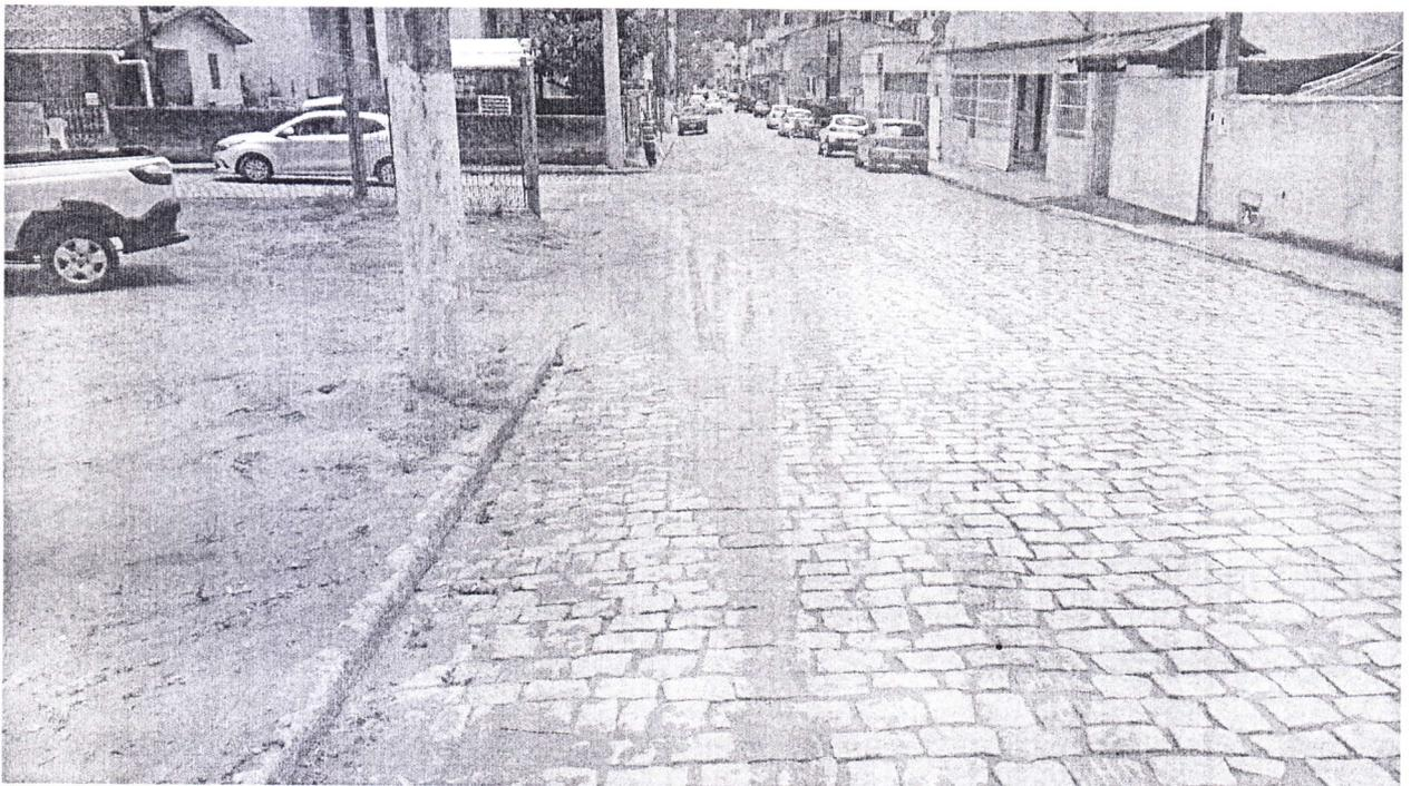
Foto 2 - ponto da rua Hilário Pasolini onde é preciso construir passeio para pedestre e soerguer o meio fio (a construção da galeria no local apontado na foto 1 impedirá o acúmulo de terra neste local)
