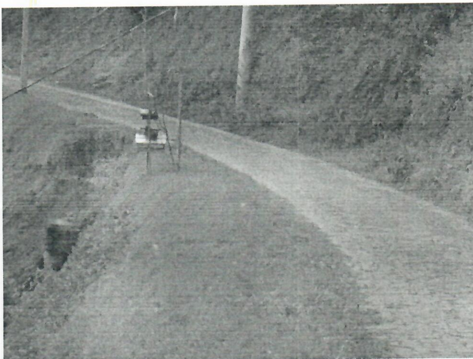
3 – Contenção de encosta na rua Maximiliano Carreta, que sustenta a rua Pedro Gasparini
