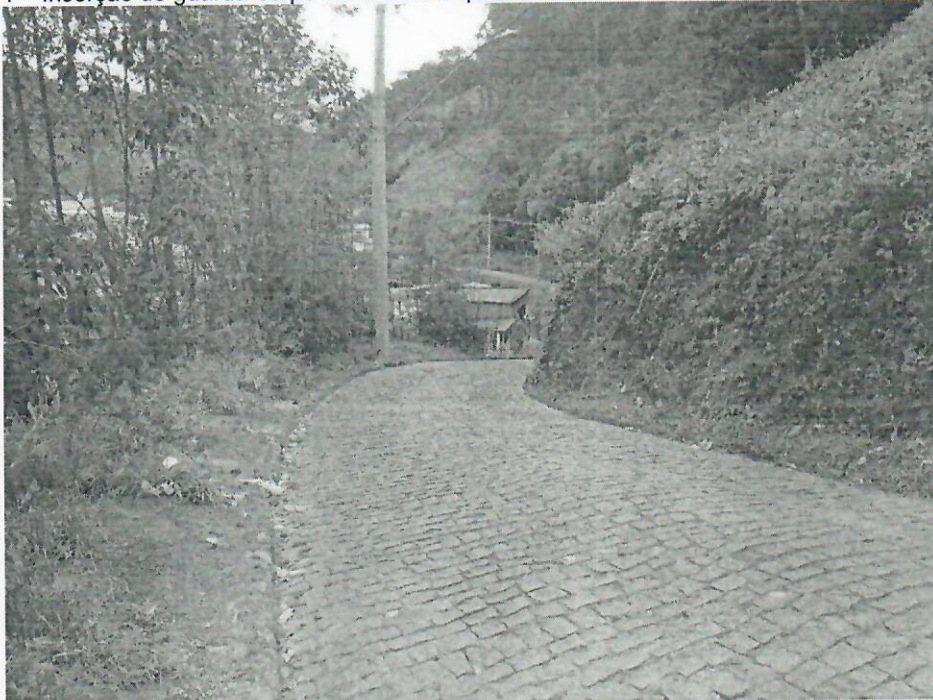
2 – Corte e reabertura da curva acentuada em frente à residência do Sr. Flávio Dalmaschio
