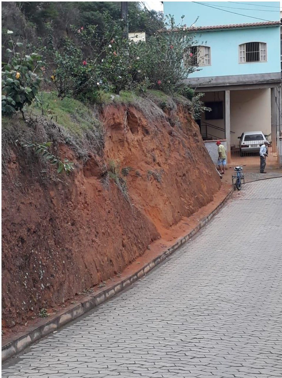
1. local da construção do muro de arrimo a fim de sustentar o talude e evitar desbarrancamento
