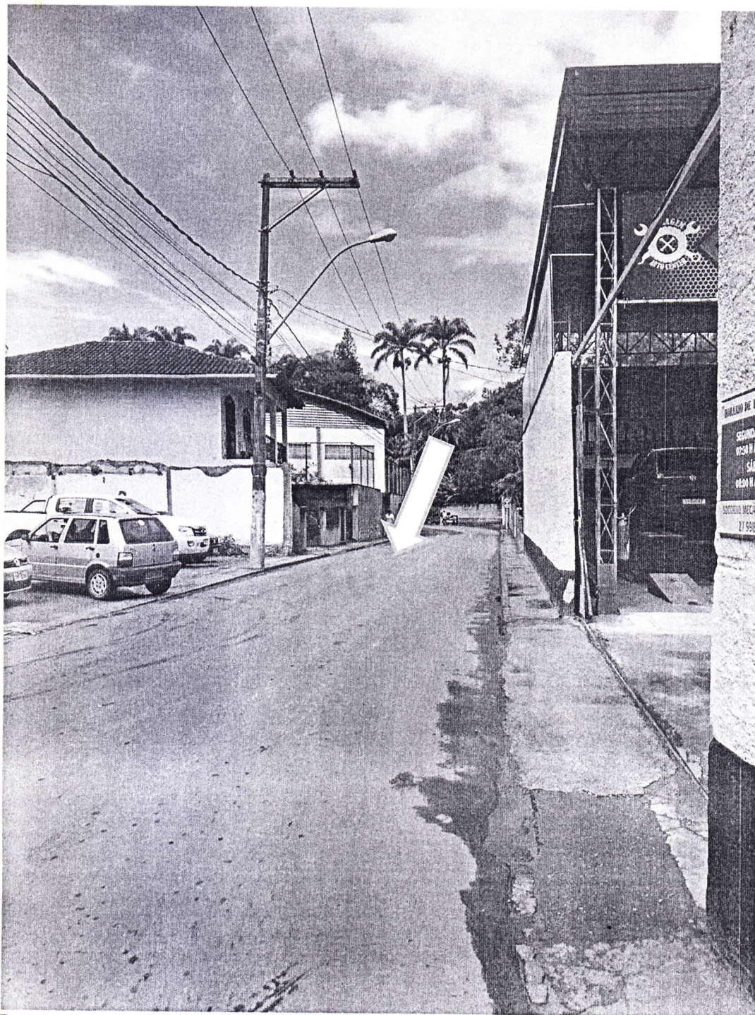
Foto 1 - vista do local aproximado onde é necessária a instalação da faixa elevada (alto risco de acidentes)
