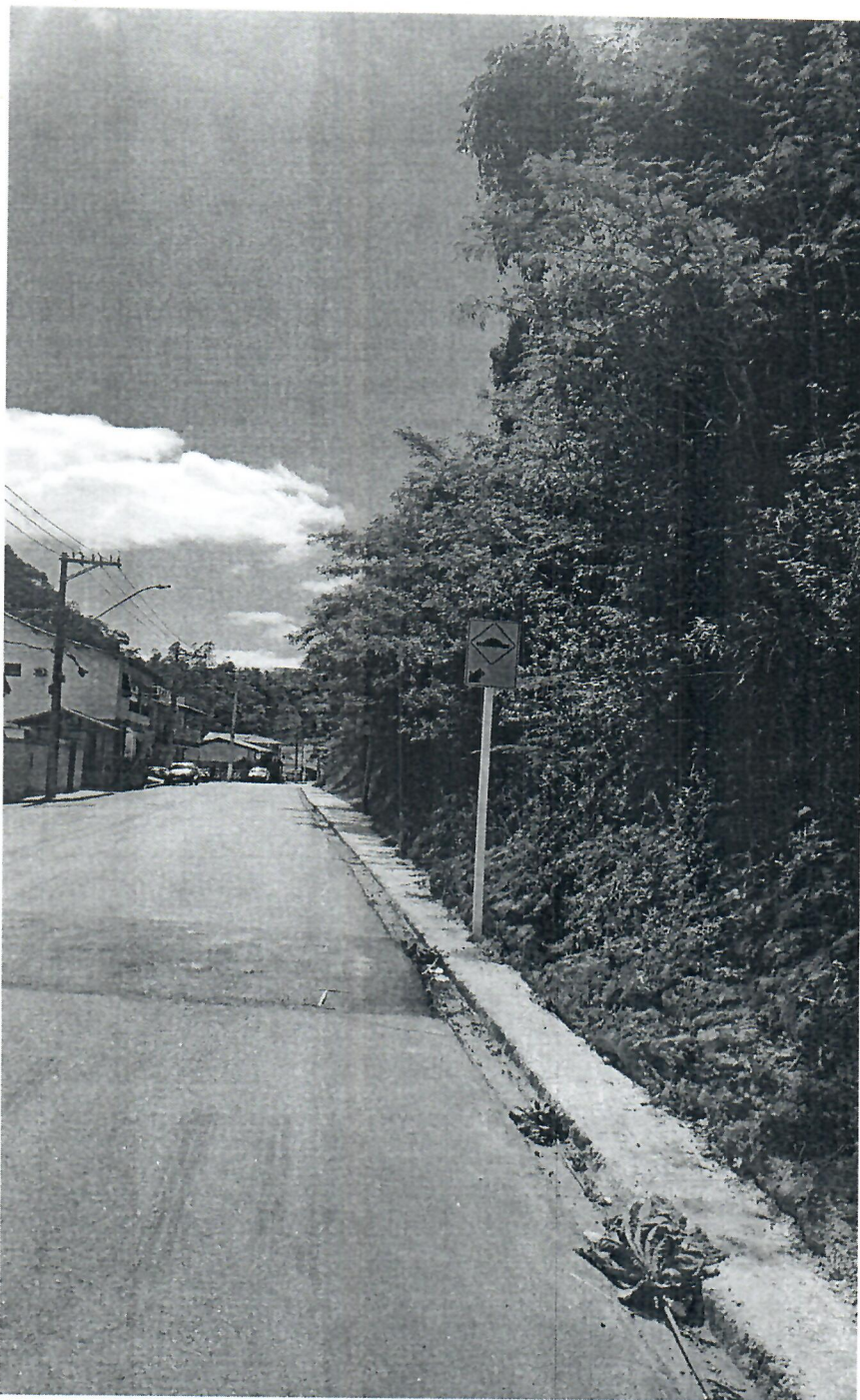
1 - vista da encosta ao longo da Rua São Lourenço, com vegetação projetando-se sobre a via.
