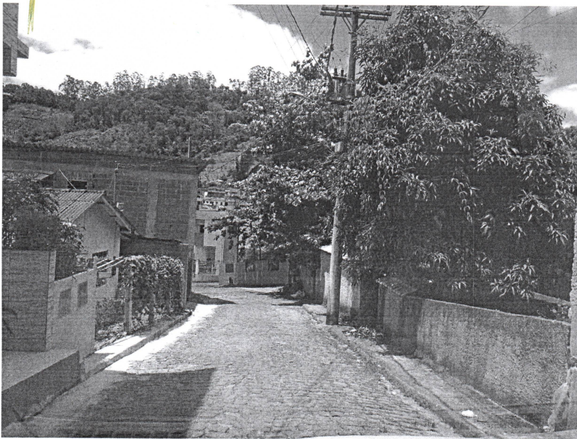
Foto 1 - vista do calçamento irregular da rua Arnaldo Gareau Moreira, no bairro Vila Nova
