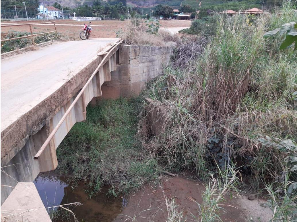
Foto 1 – vista da estrutura da ponte sem o guarda-corpo em um dos lados (risco aos usuários)
