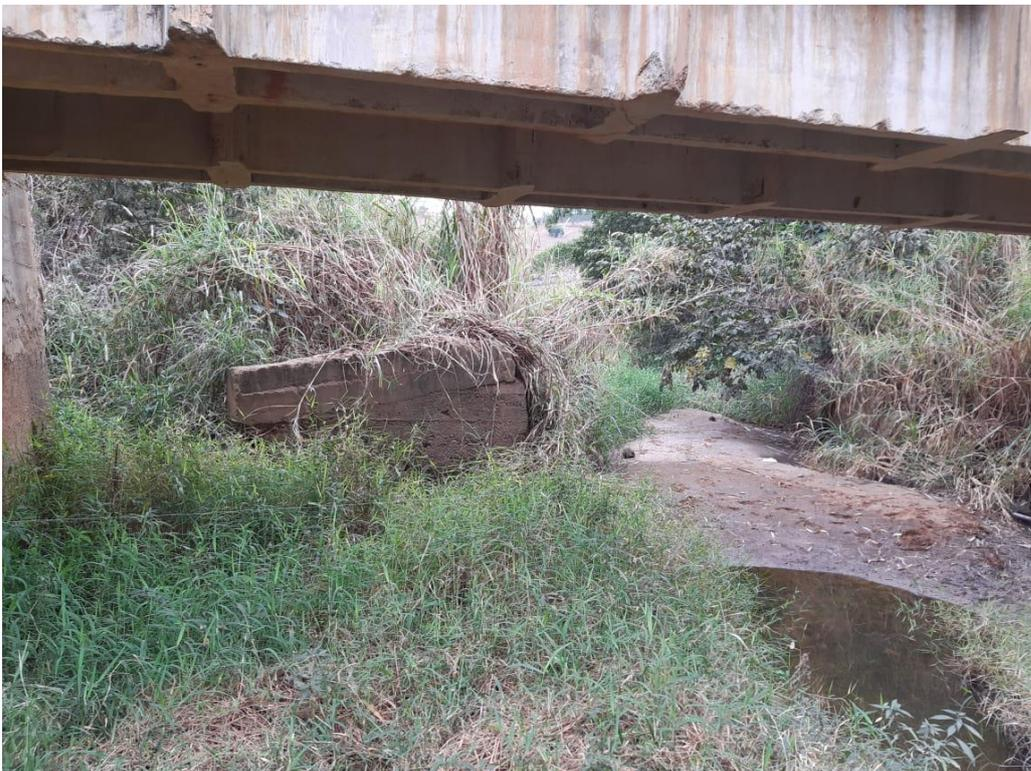
Foto 2 – vista dos restos de alvenaria da ponte antiga que obstruem o fluxo d'água no período chuvoso
