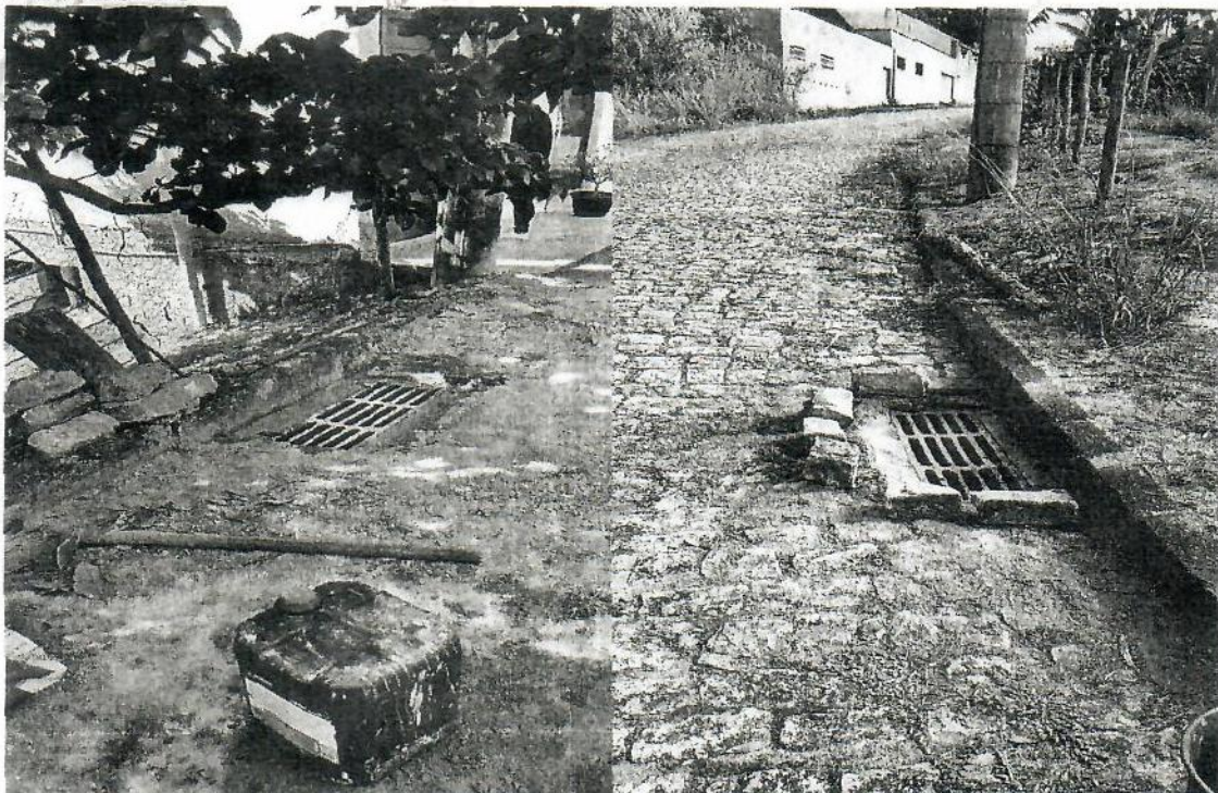
INSTALAÇÃO DE TAMPAS DE BUEIRO NA RUA DAS HORTÊNCIAS
