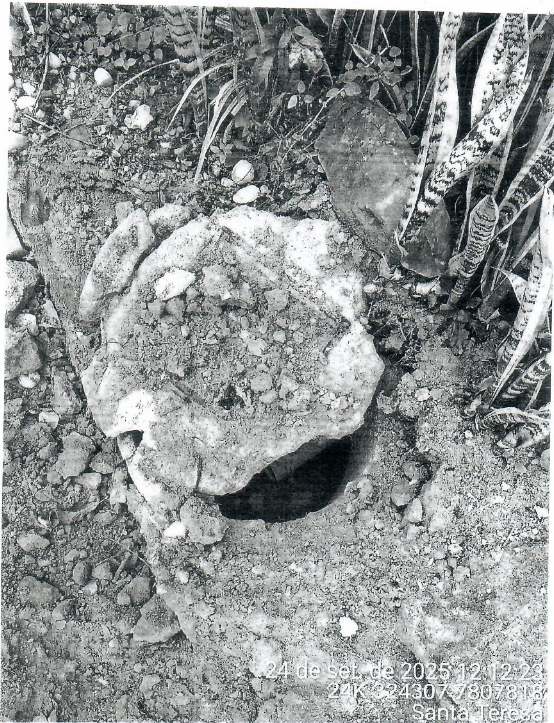
Obstrução da rede primaria de esgoto
