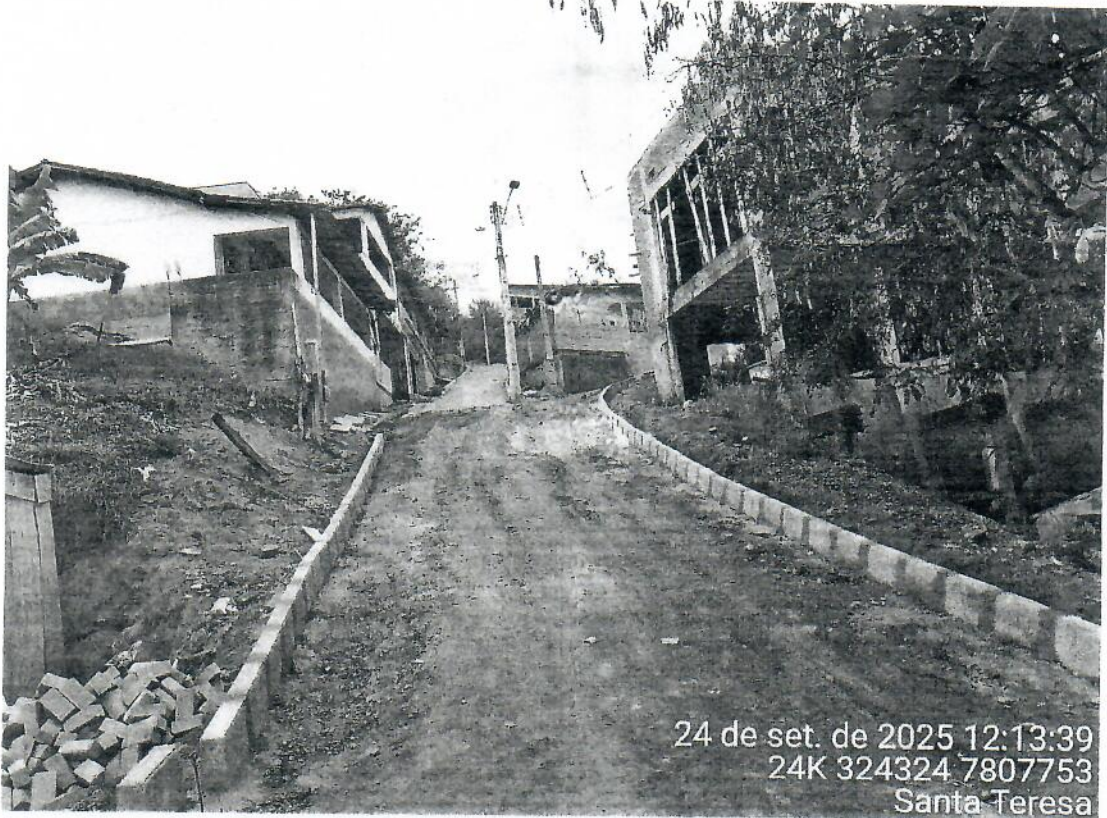
Desnivelamento e desalinhamento do meio fio
