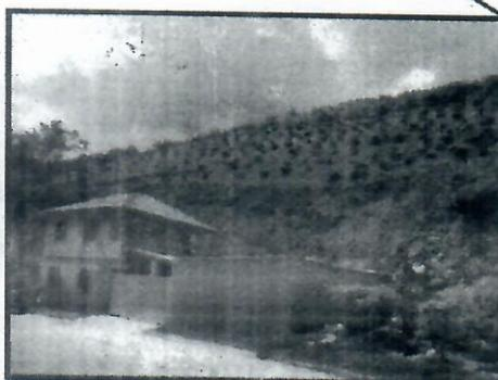
**Descrição:** Residências construídas em solo que esta em contato com rocha de foliação de alto ângulo, mergulhando em direção à estrada. O contato solo/rocha constitui um plano de descontinuidade favorável a deslizamentos. Há também áreas desmatadas na encosta mais a cima. **Aproximadamente 20 pessoas.**
