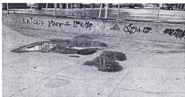
Foto 13 - Pista de Skate sem a devida conservação e com acúmulo de água.
