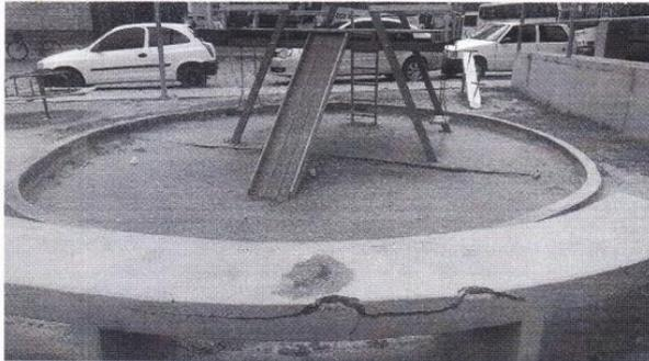
Imagem 03 - Areia insuficiente/suja; estrutura do banco danificada
