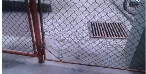
Foto 06 – Quadra poliesportiva com várias partes do alambrado deterioradas.
